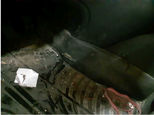
Beschädigung 6: Verkleidungen/Abdeckungen: Teppichboden vorn links - verschlissen - erneuern
