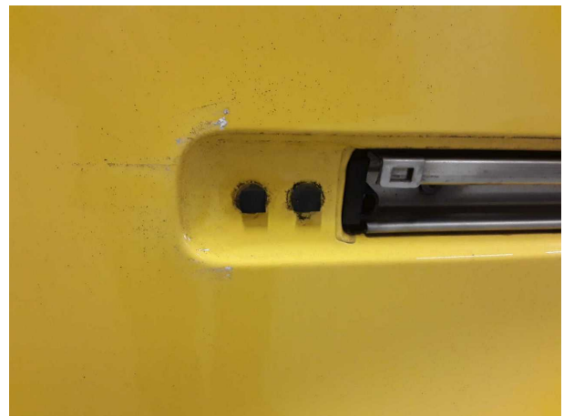
Beschädigung 2: Schiebetür rechts: Führungsschiene (Blende) - fehlt - erneuern
